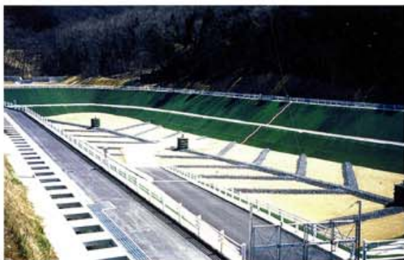
◆上部町一般廃棄物最終処分場(兵庫県赤穂郡上部町)
