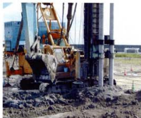
「下松石炭中継基地」FC-DCM施工状況
